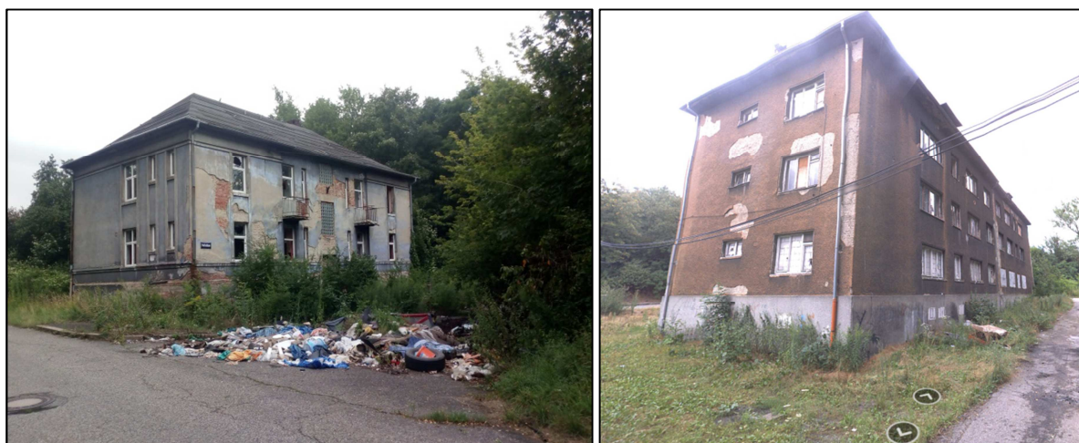
Obrázek 18 Prázdný dům na ulici Verdiho, druhý objekt (vpravo) již nestojí (zdroj: mapy.cz)
