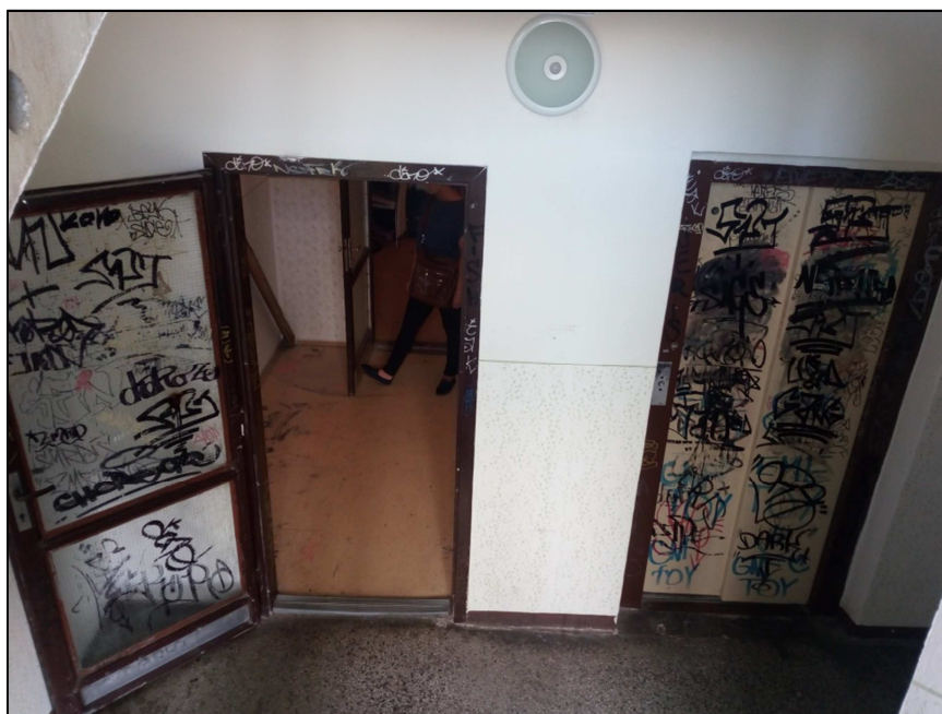
Obrázek 10 Interiér obecního bytového domu na adrese Václava Košaře
