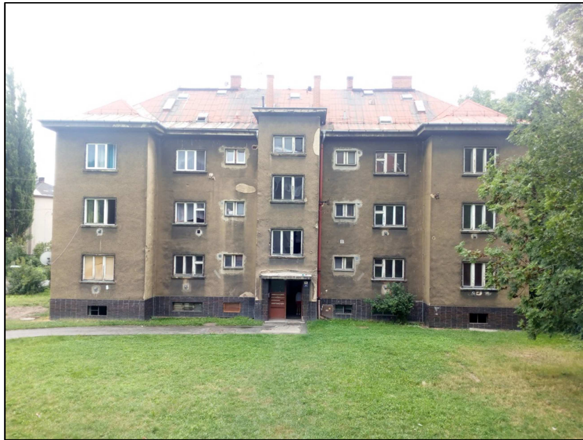
Obrázek 16 Dům č.p. 12 na ulici Plechanovova (obecní)
